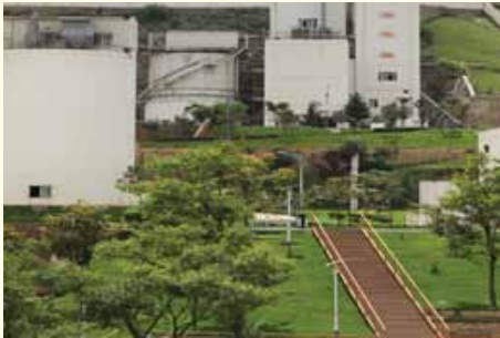
膏体充填系统
